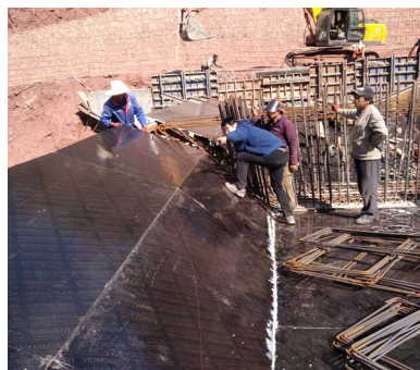
同济大学挂职永安村第一书记孙羽捷（第三任） 监督现场施工
