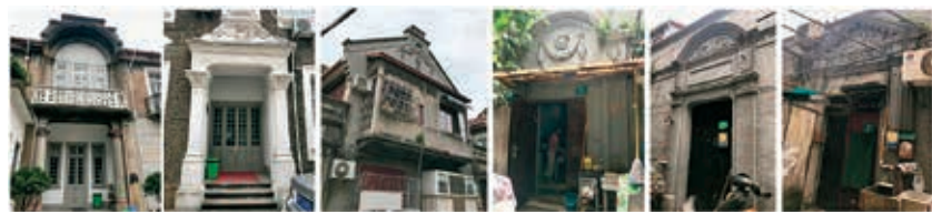
图8, 提篮桥地区北部地带现状历史建筑风貌构件
