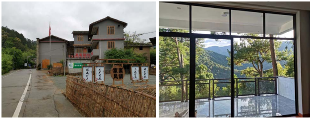
图 12，月洲村房前屋后改造（左）大喜村特色民宿改造（右）
